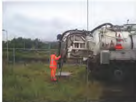
Reinigen en inspecteren riolering
