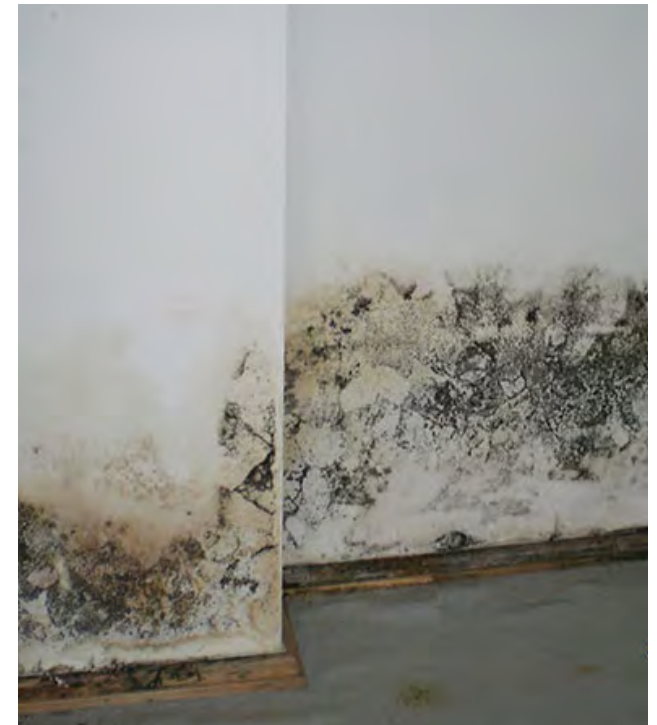
grondwateroverlast optrekkend vocht
